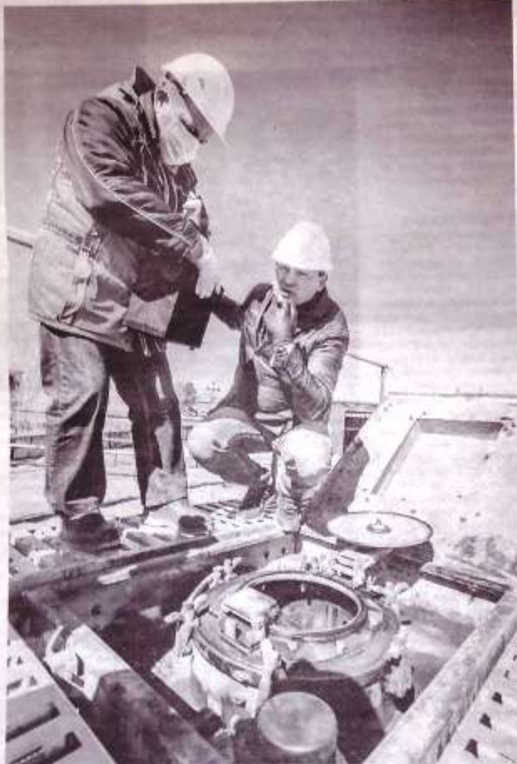
Замер на крыше автоцистерны не выявил превышений норм выбросов.
