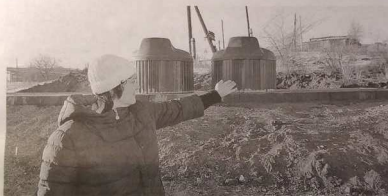
Площадка раздора. Видно, что машине к ней подъехать будет трудно.
